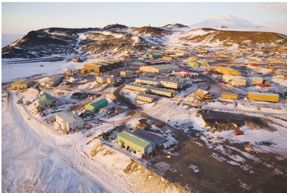
Рис. 10. Научная станция в Антарктиде
