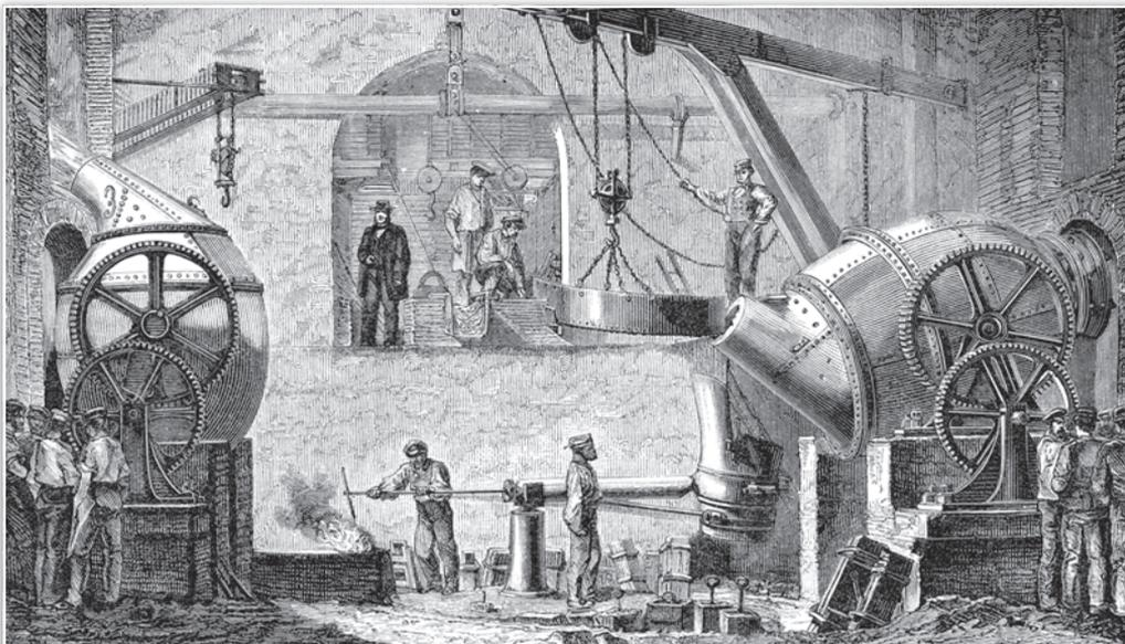
Выплавка стали в конвертере Бессемера. Гравюра. 1886 г.
